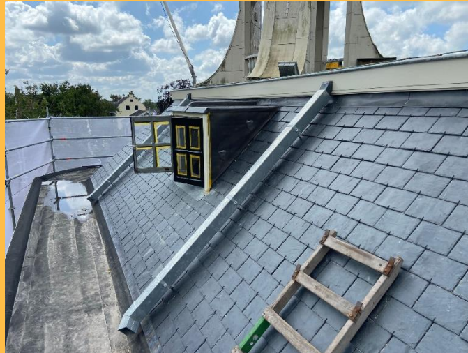
Het nieuwe dak met de beschreven leien
